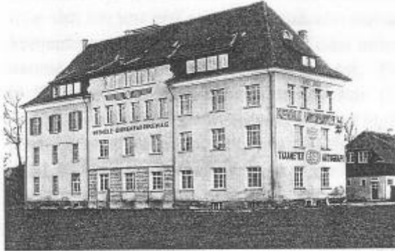
Kienzle Werksgebäude (1925) in der Prinz-Eugen-Straße (am Eisweiher).
