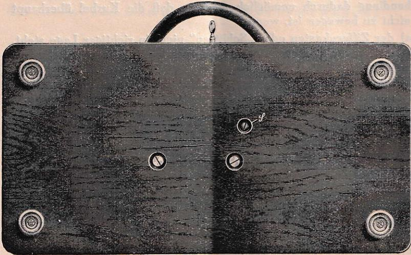
Um das Werk der Maschine auf dem Transporte vor Beschädigung zu schützen, ist an der Unterseite des Fußes bei s eine Schraube angebracht. Nach Ankunft ist diese Schraube sofort zu entfernen (jedenfalls vor irgendeiner Kurbeldrehung) und der durch sie vorher festgehaltene Schlitten z etwas nach links zu verschieben, bis der kleine Pfeil links auf l zeigt und der Schnepfer (Taste am vorderen Teil des Ziffernkastens) hörbar einfällt, womit der Schlitten seine Grundstellung erreicht hat.
